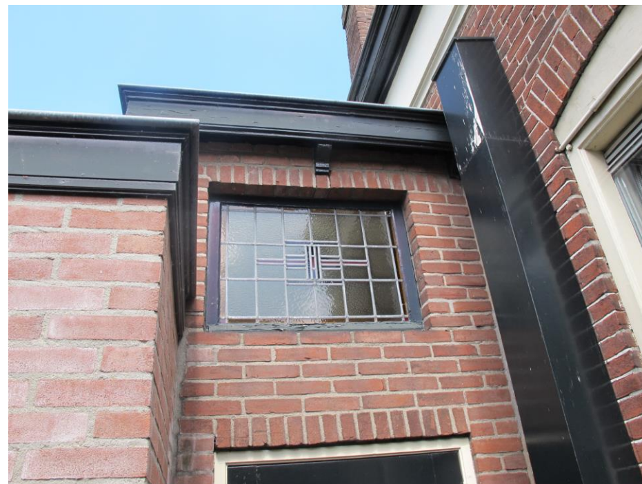
Het bovenlicht met glas-in-lood raam in de uitbouw uit de jaren 30.
