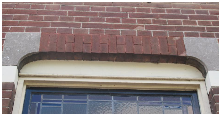
Detail van een vensterafsluiting in de voorgevel. Let op het rode voegwerk tussen de stenen van de rollaag. De oorlogsschade is in mortel gerepareerd.
