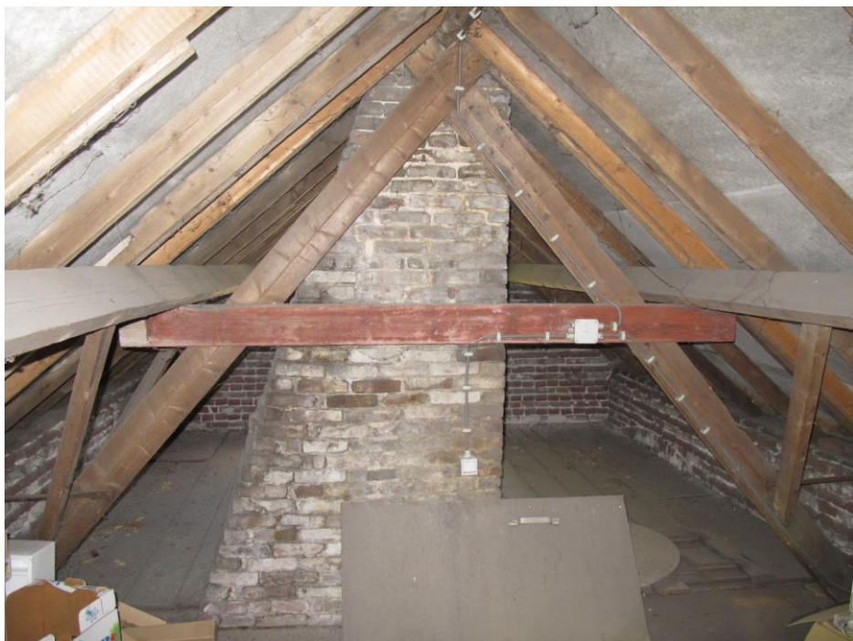
Zicht op de zolder van de schuur naar het noorden. De kap is deels met gebruik van oudere elementen na de oorlog opnieuw gebouwd.
