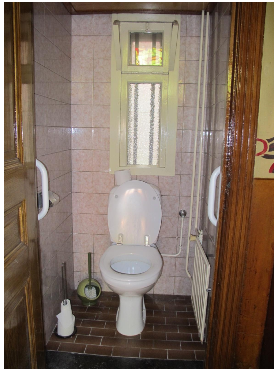
Het toilet naast de trap. Sanitair en afwerking wanden en vloer is niet oorspronkelijk.
