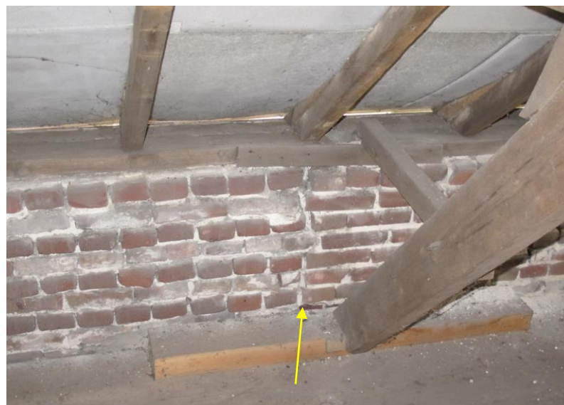
Bouwnaden (zie gele pijlen) in de borstwering van de west- en oostgevel van de schuur die wijzen op een latere uitbreiding in zuidelijke richting.
