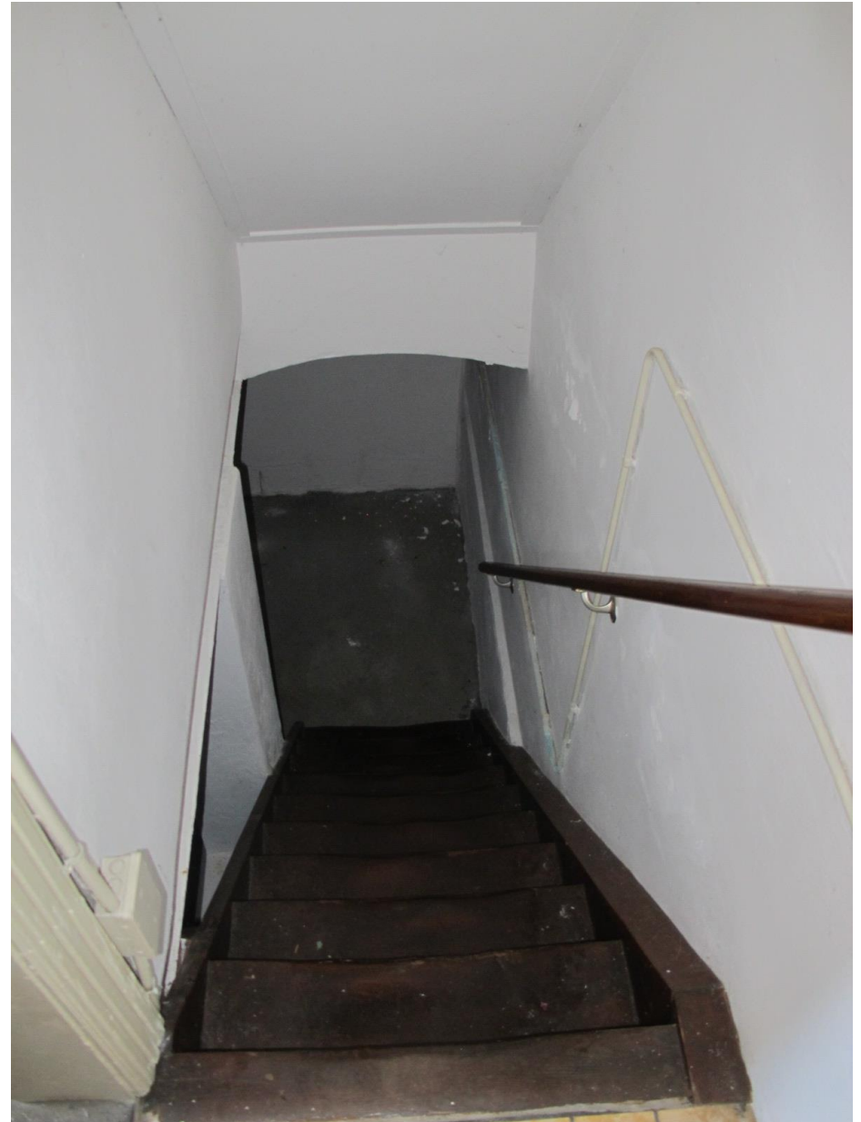
De trap naar de kelder.
