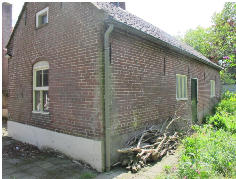
De noord- en de westgevel van de schuur.
