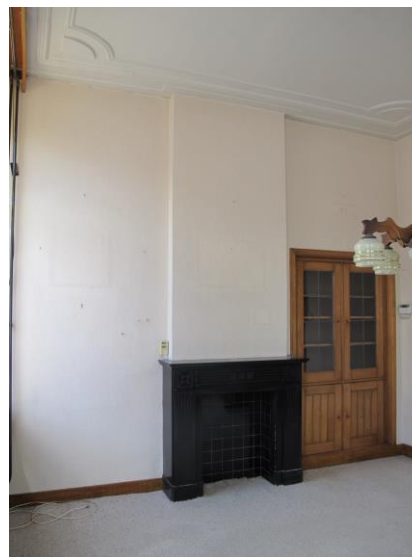
De zuidwand van de voorkamer met stookplaats en wandkast. De deuren zijn in de jaren 50 gemoderniseerd.
