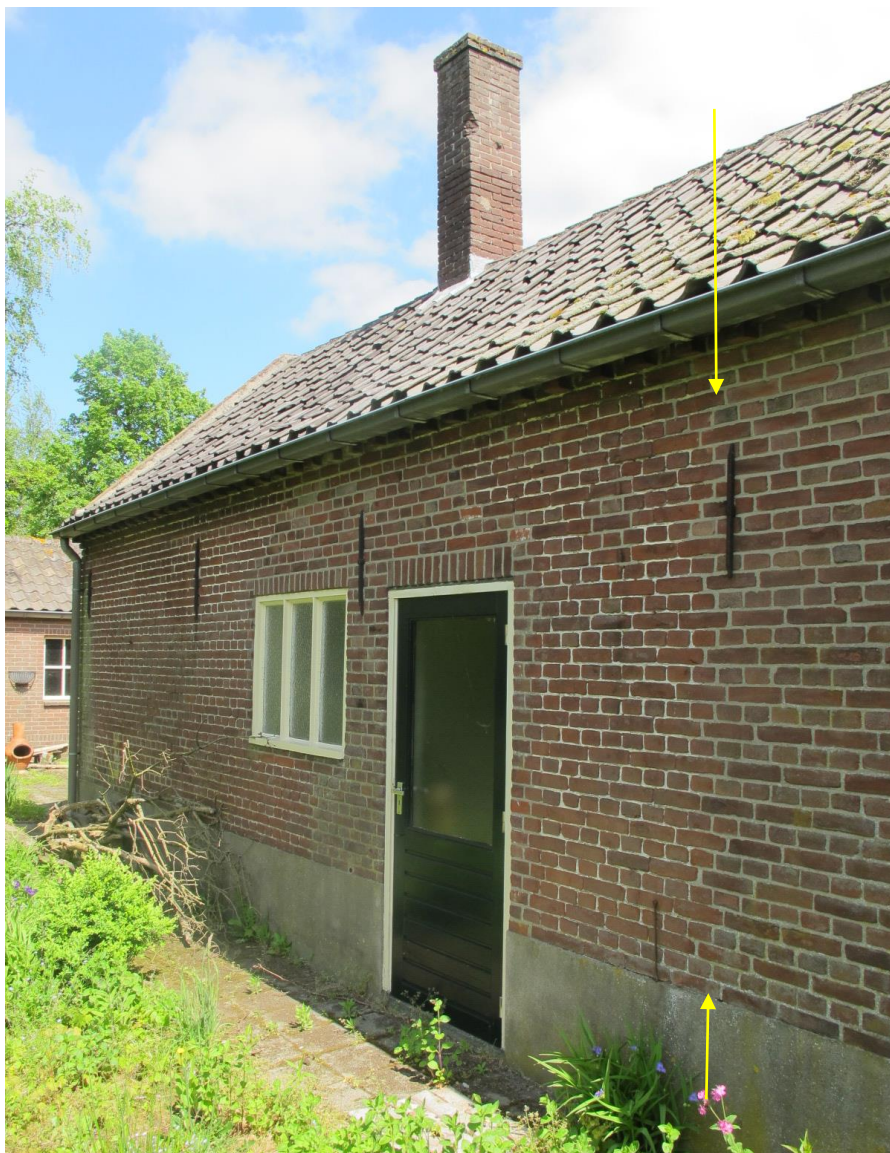
De westgevel van de schuur. De gele pijlen duiden een vermoedelijke bouwnaad aan, waarbij het gevelwerk rechts jonger (jaren 50?) lijkt te zijn. Ook de deur en venster zijn later ingebroken in het oude werk.
