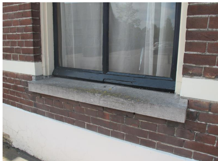
Onderzijde met hardstenen lekdoorpel van een voorgevelvenster.
