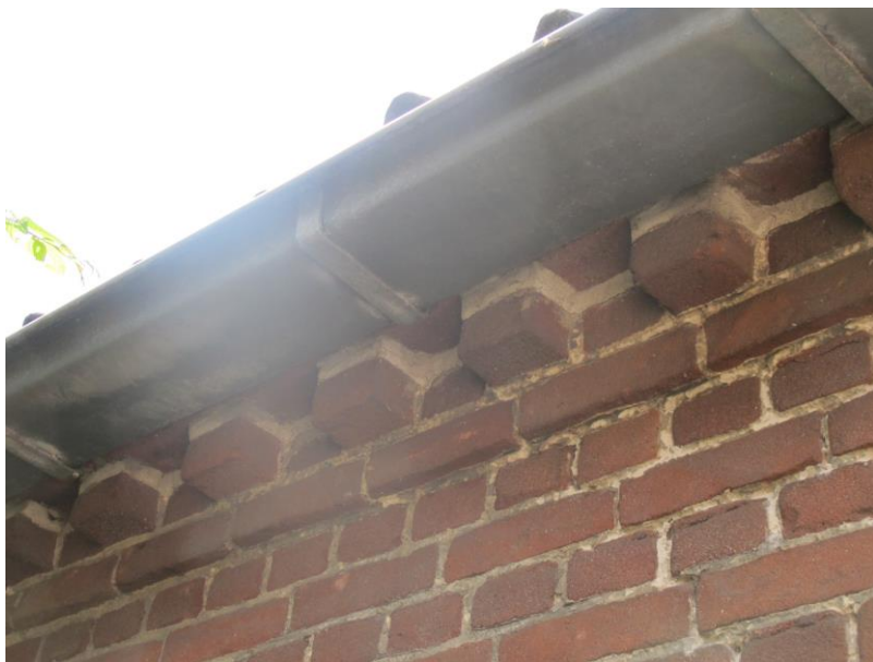
Detail bloktandlijst van de oostgevel van het bakhuis/schuur.
