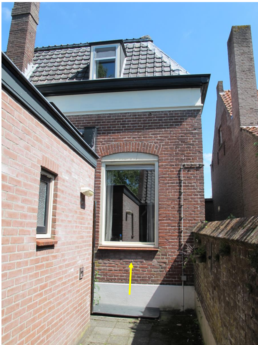
Rechter deel rechter zijgevel. De gele pijl wijst naar het oorspronkelijke dorpelniveau van het keukenvenster. Links de badkamer uit de jaren 70.
