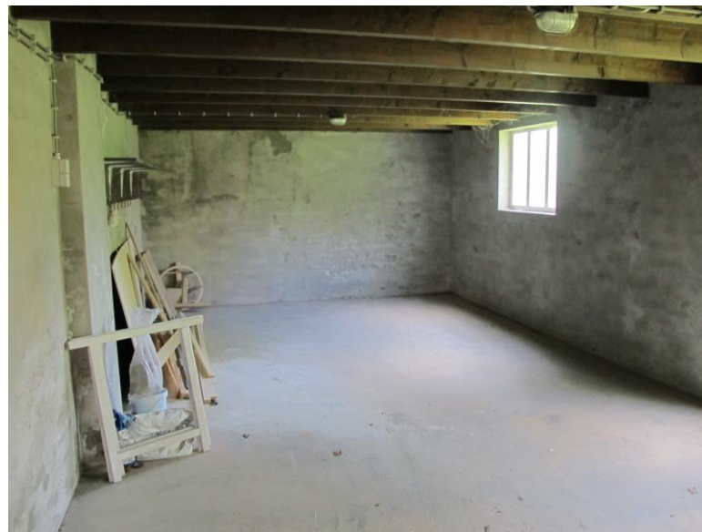
Interieur van de schuur naar het zuiden. De balklaag is van jongere datum (jaren 50?)
