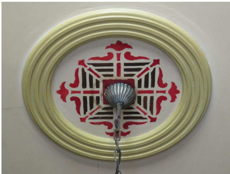
De originele stucrozet met jongere sjabloonschilderingen van het plafond van de gang.
