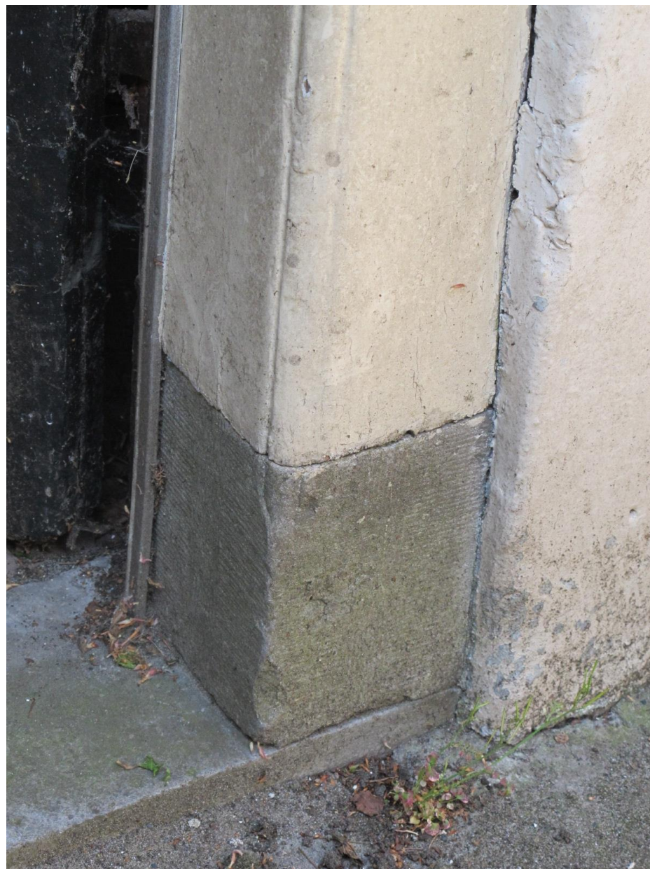
Hardstenen neut, dorpel en zwaar houten kozijn met kraalprofiel van het bakhuis.
