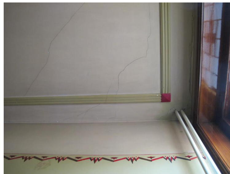
Het sjabloonfries in Art Deco-vormen en deel van het plafond in de gang.
