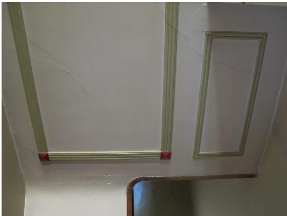
Detail van het plafond in de gang voor het trappenhuis.
