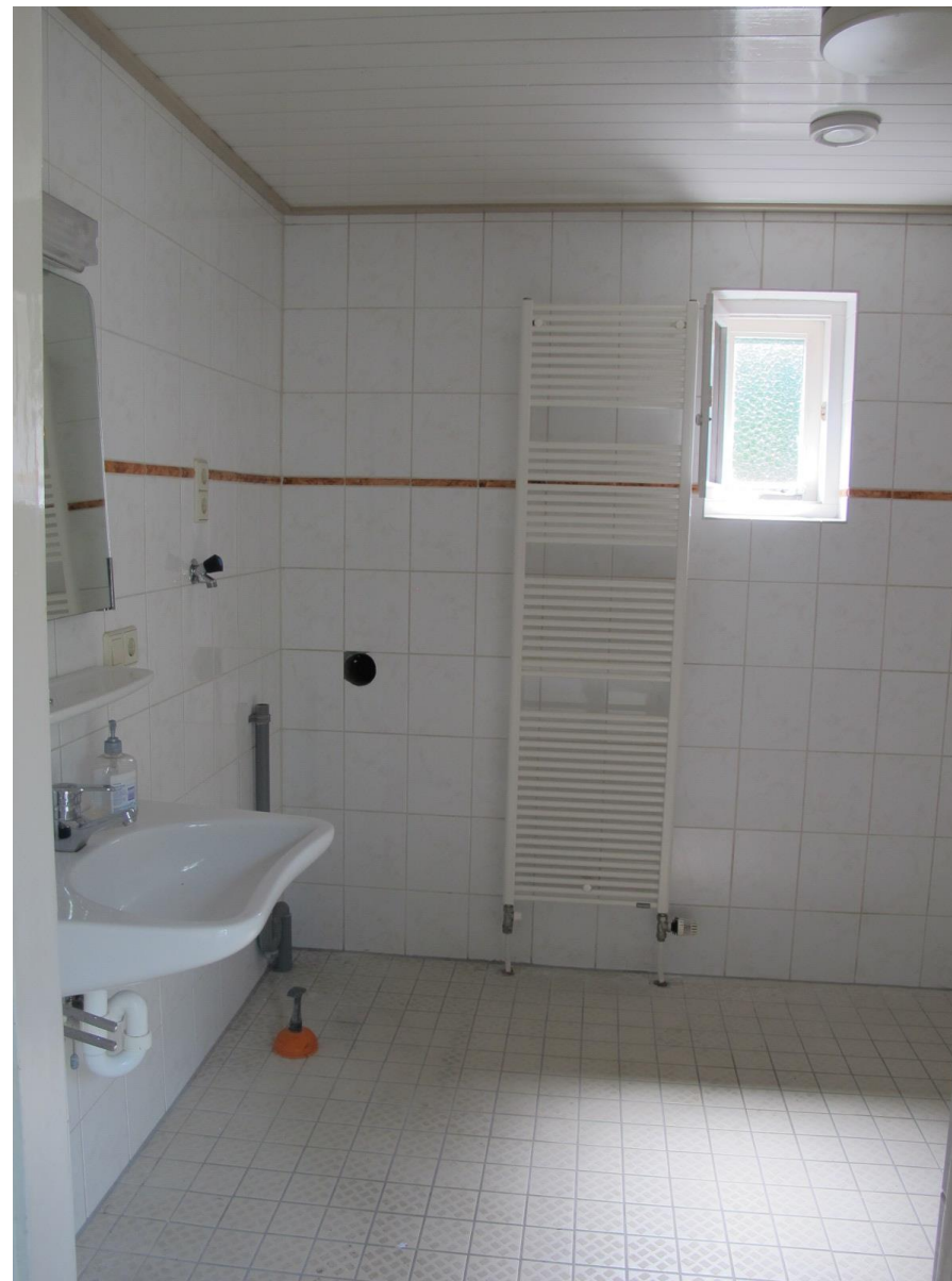
Interieur van de badkamer.
