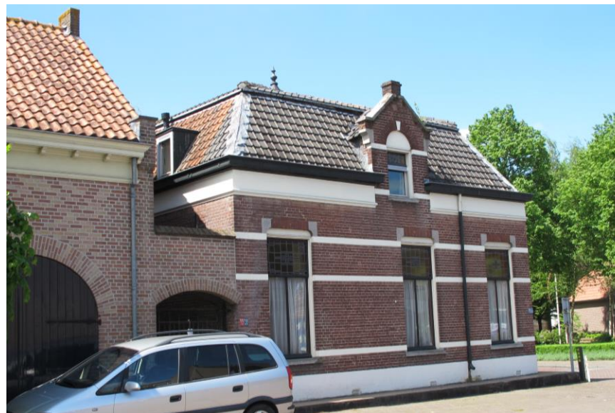
De zijgevel en een deel van de achtergevel. Let op de rode pannendekking op het achterschild!
