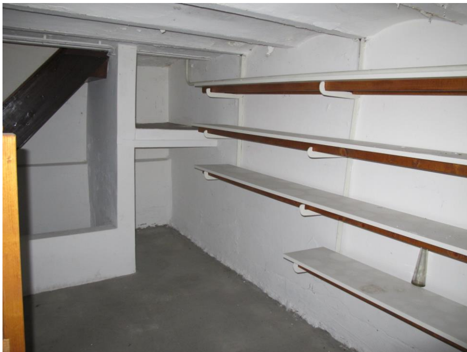
De kelder naar het oosten gezien.
