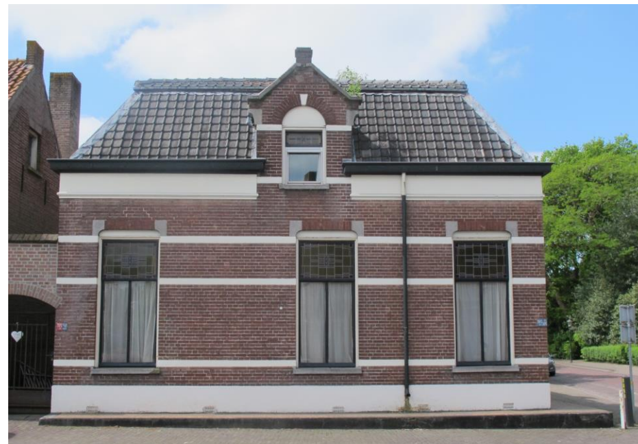
Zicht op de op het middenvenster na symmetrisch opgezette linker zijgevel.
