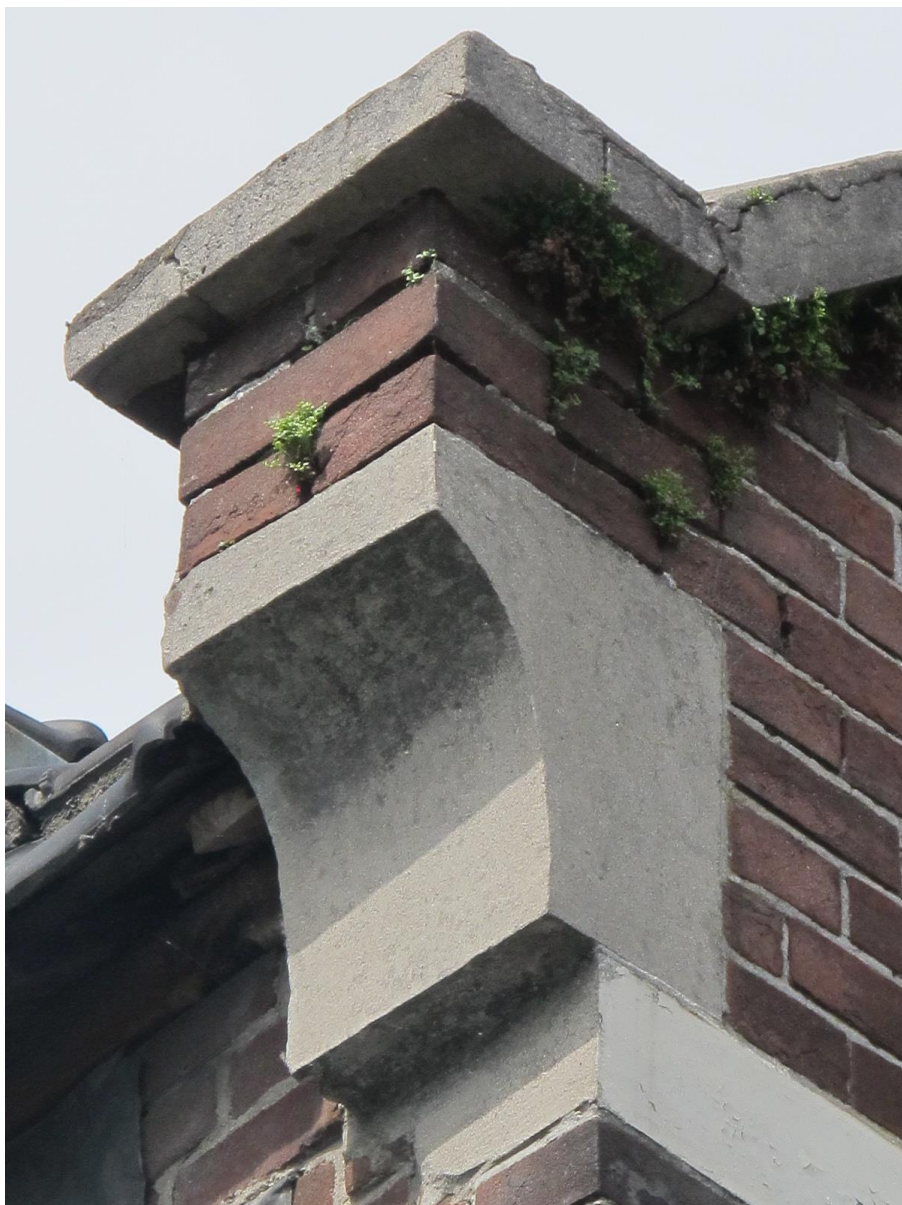
Detail uitkragend schouderstuk van de Vlaamse gevel van de linker zijgevel.
