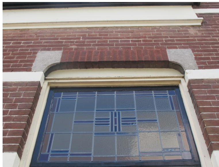
Detail van een bovenlicht van een voorgevelvenster.
