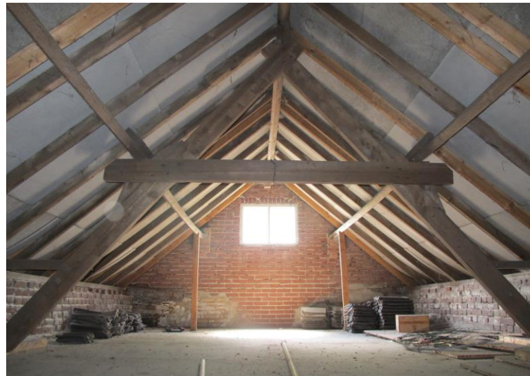
De zolder van de schuur naar het zuiden gezien. Ook de kap is van jongere datum.
