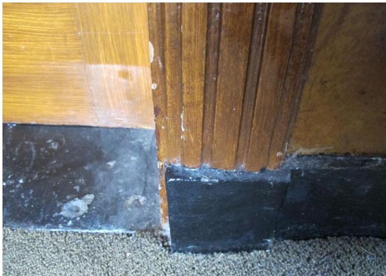
Detail van een deurkozijn met neut en hardstenen dorpel in de gang.
