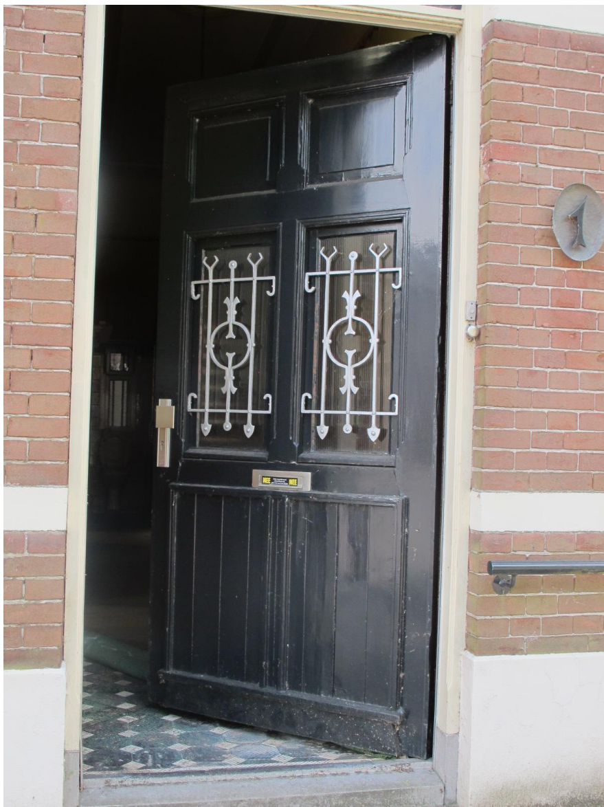
De voordeur in geopende toestand. De oude tegelvloer van de gang is zichtbaar.
