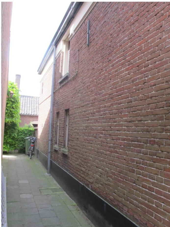
Zicht langs de achtergevel, op de achtergrond het bakhuis.
