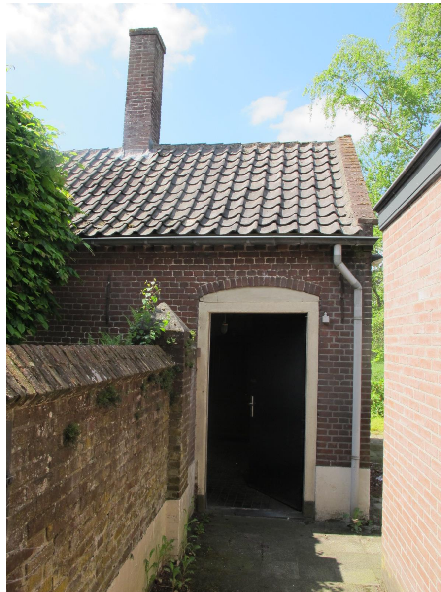
Zicht op de ingang in de oostgevel naar het bakhuis. Links de oude scheidingsmuur tussen schoolerf en erf van de woning.
