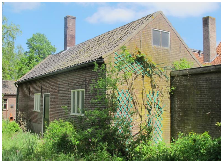
De zuid- en westgevel van de schuur. Rechts de achtergevel van de voormalige privaten van de school.
