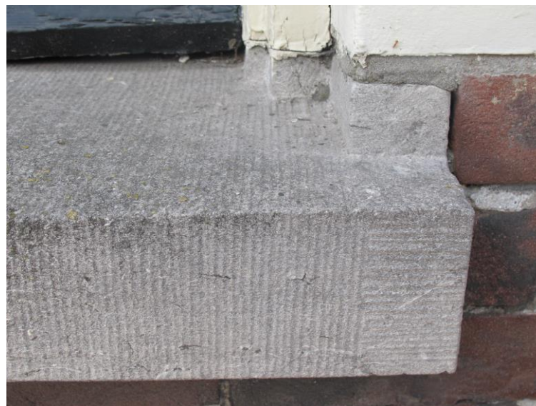
Detail van de frijnslagafwerking van een vensterdorpel.
