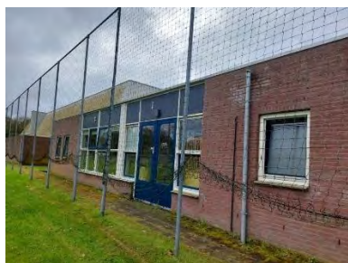
Figuur 2.6 Sfeerimpressie, gedeelte van het te slopen bebouwing.
