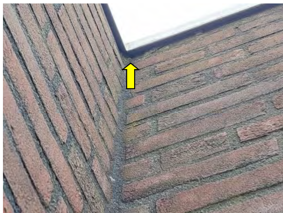
Figuur 5.2 Ruimte onder daklijst.
