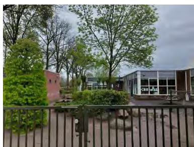
Figuur 2.3 Sfeerimpressie, te slopen bebouwing (rechts) en berging (links).
