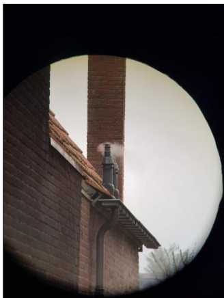
Figuur 8. Zuidoostzijde aanbouw
