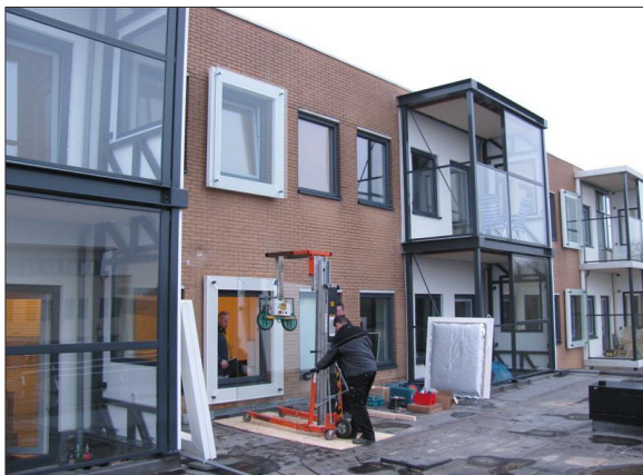
Foto II.1 Aanzicht glazen gevelgeluidschermen
