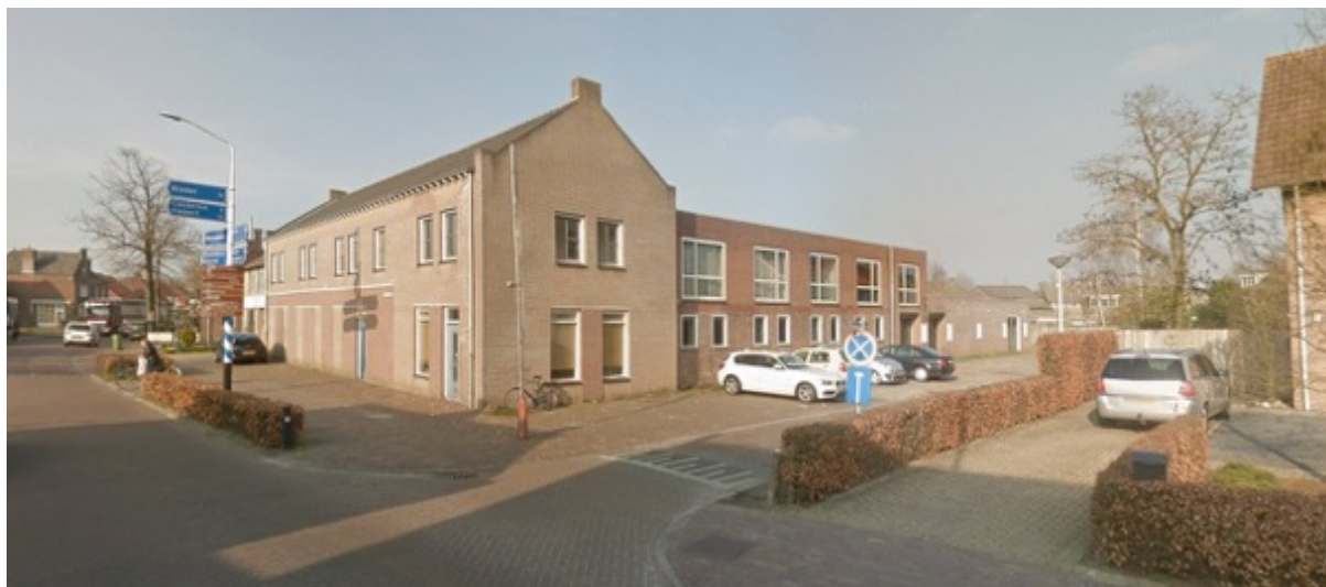
Foto bestaande situatie met zicht plangebied vanaf zuidelijker richting van de Doorboomstraat gezien; bron: GoogleStreetview 2020
