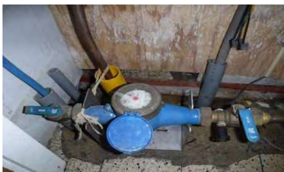
Doorvoeringen niet asbestverdacht
