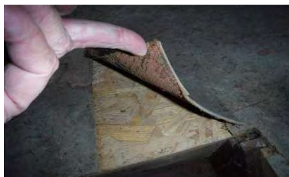
Inspectie onder het niet asbestverdachte vloerzeil
