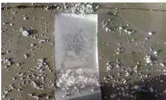
Inspectie onder de p.v.c. dakbedekking
