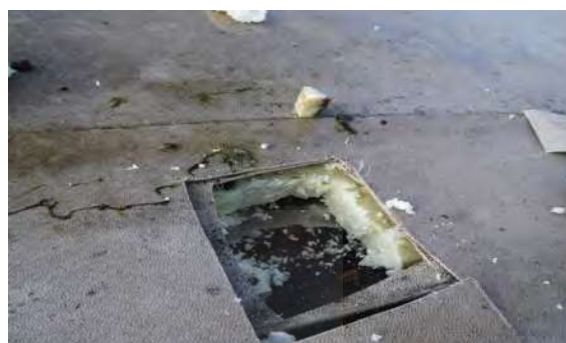
Inspectie onder de p.v.c. dakbedekking
