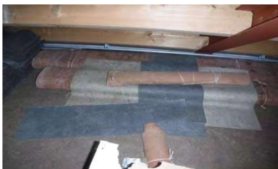
Vloerzeilen in de bovenwoning niet asbestverdacht
