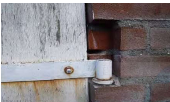
Inspectie in de spouwmuur
