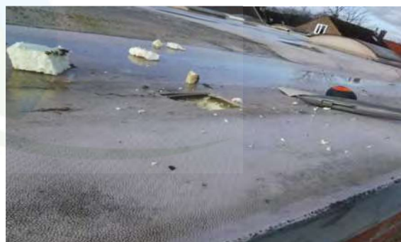
Inspectie onder de p.v.c. dakbedekking
