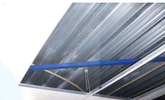
Dak stalen damwand
