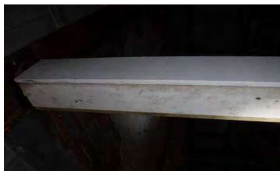
Bekleding stalen kolom Promatect
