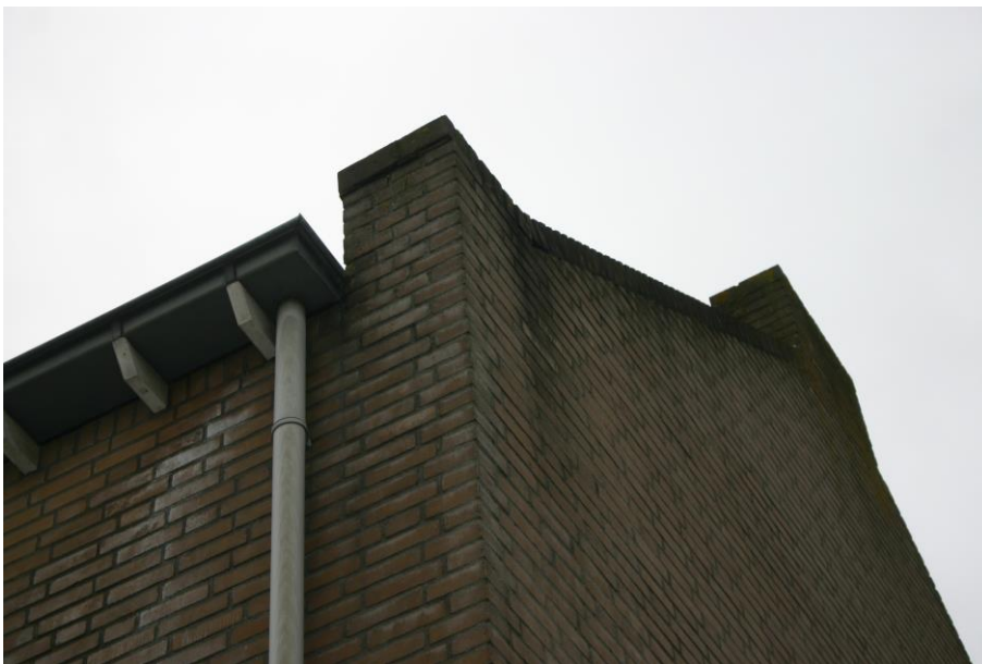
Figuur 4.4.2. Overstekende gevelpannen zijn afwezig op het gebouw met het pannendak.
