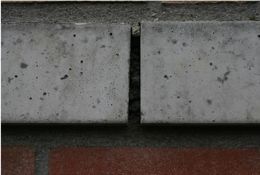
Figuur 4.4.3. De openingen in de voorgevel van het meest zuidwestelijke gebouw geven geen toegang tot de spouw.
