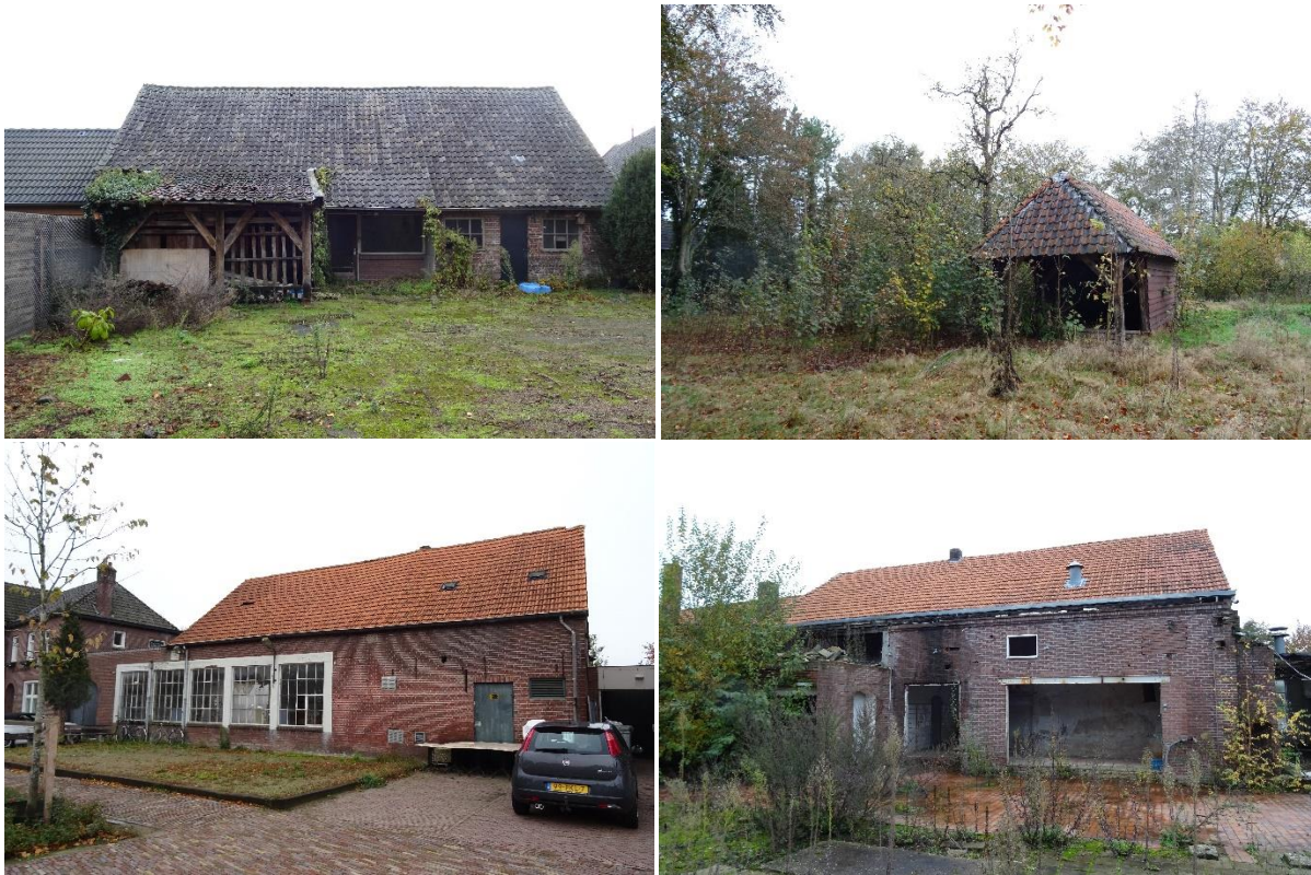
Afbeelding 5, 6, 7 en 8: Bestaande te slopen bijgebouwen op de kavel. Bron: R.J.L. Bijvelds 20-10-2020
