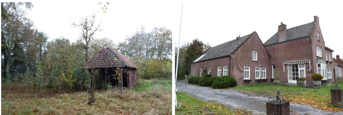
Afbeelding 3 t/m 6: De projectlocatie met te slopen en behouden verbouwen bebouwingen. Bron: BNL advies, datum: 20-10-2020
