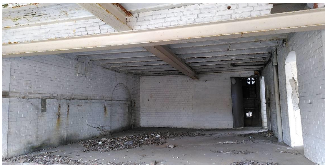
35. Limonadefabriek – interieur noordelijk deel
