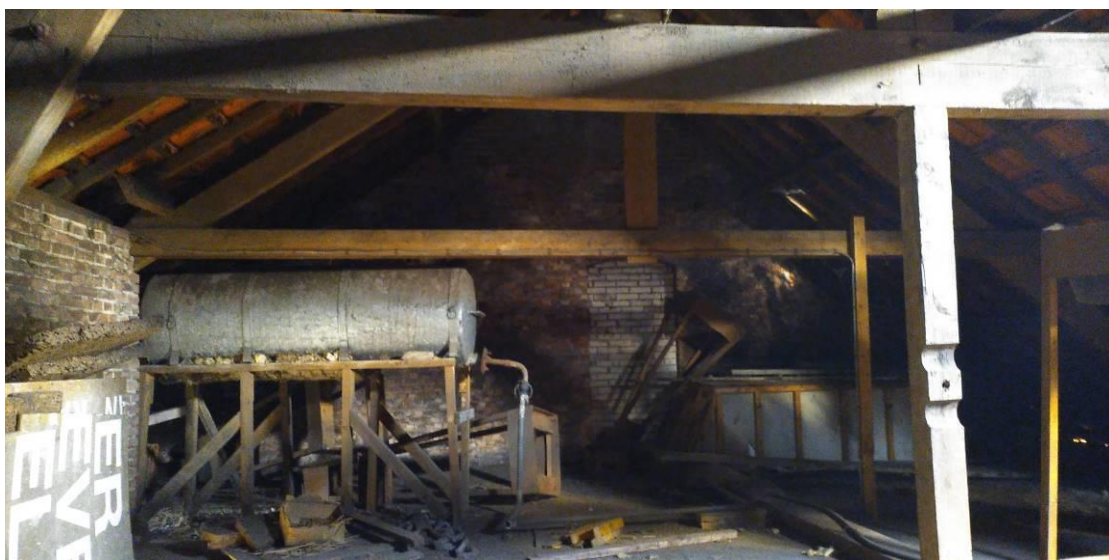
36. Limonadefabriek – zolderverdieping met kapconstructie.
