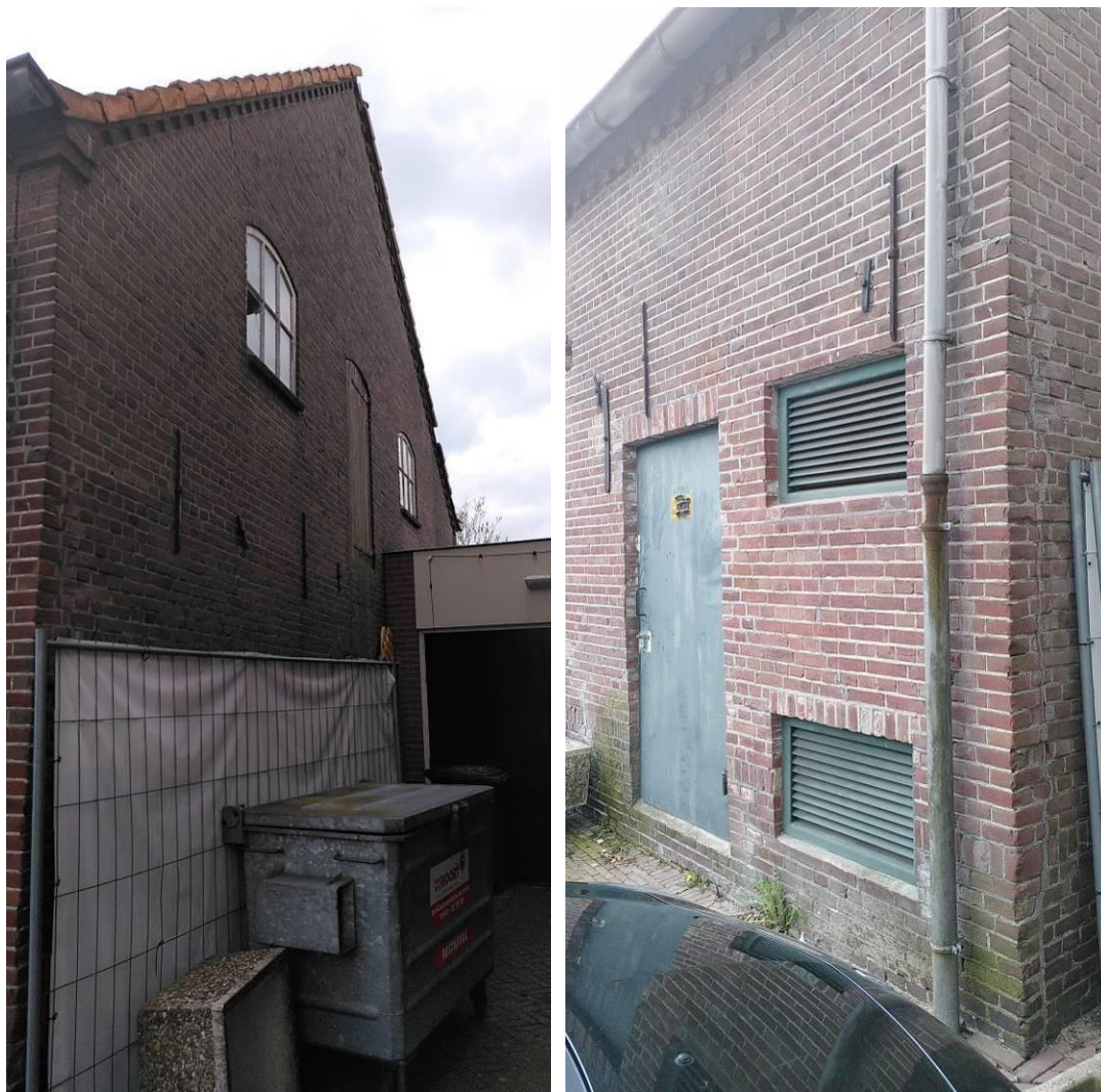
27. en 28. Limonadefabriek - noordelijke zijgevel en rechterzijde voorgevel
