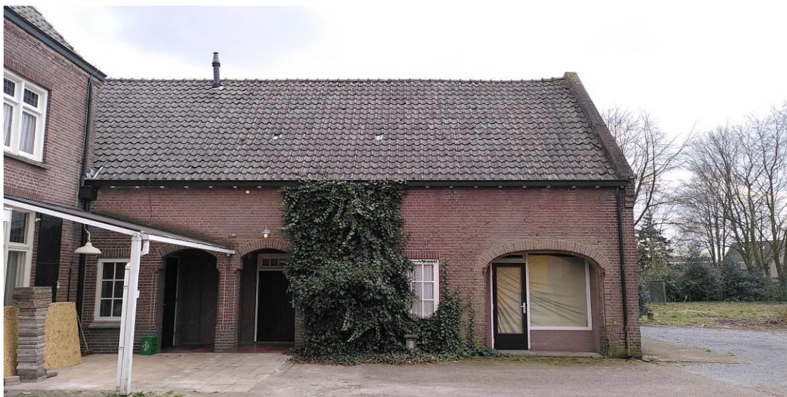
38. Bottelarij – noordelijke langsgevel
