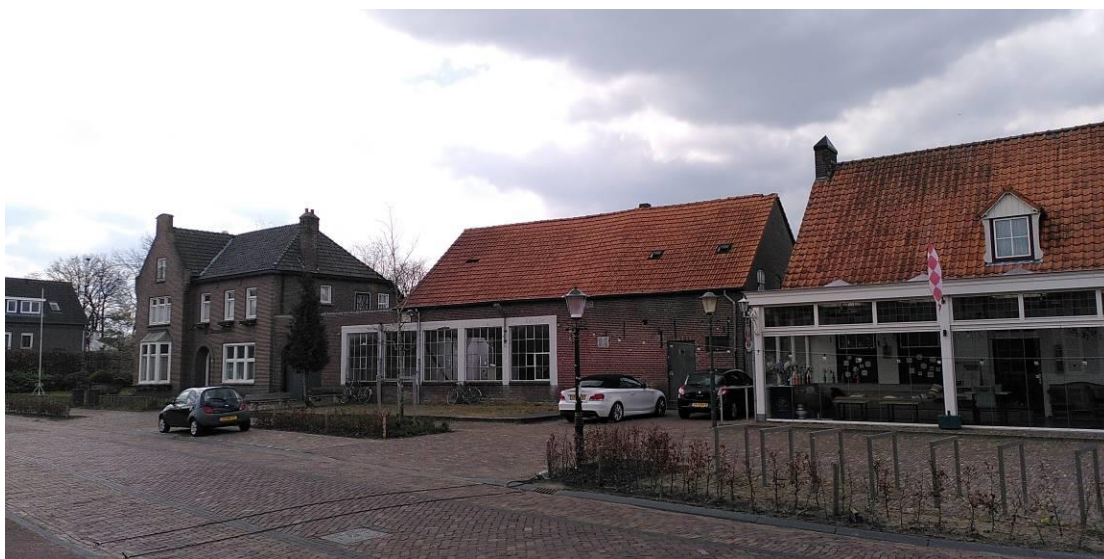
47. Villa en limonadefabriek gezien vanuit de Doornboomstraat, rechts café-zaal De Doornboom
