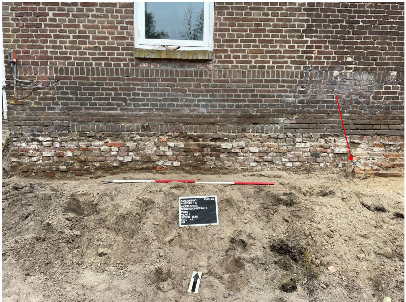
Figuur 21. De westelijke aanbouw van de bottelarij is herkenbaar als een afwijkende fundering, bij de rode pijl is de staalfundering van de oorspronkelijke bouw zichtbaar.
