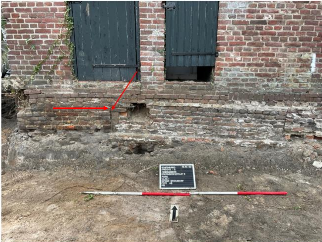
Figuur 20. De westelijke helft van de zuidgevel van de brouwerij, bij de rode pijl is duidelijk zichtbaar dat er een andere fundering aanwezig is en de nieuwe fundering koud tegen de oude is geplaatst.
