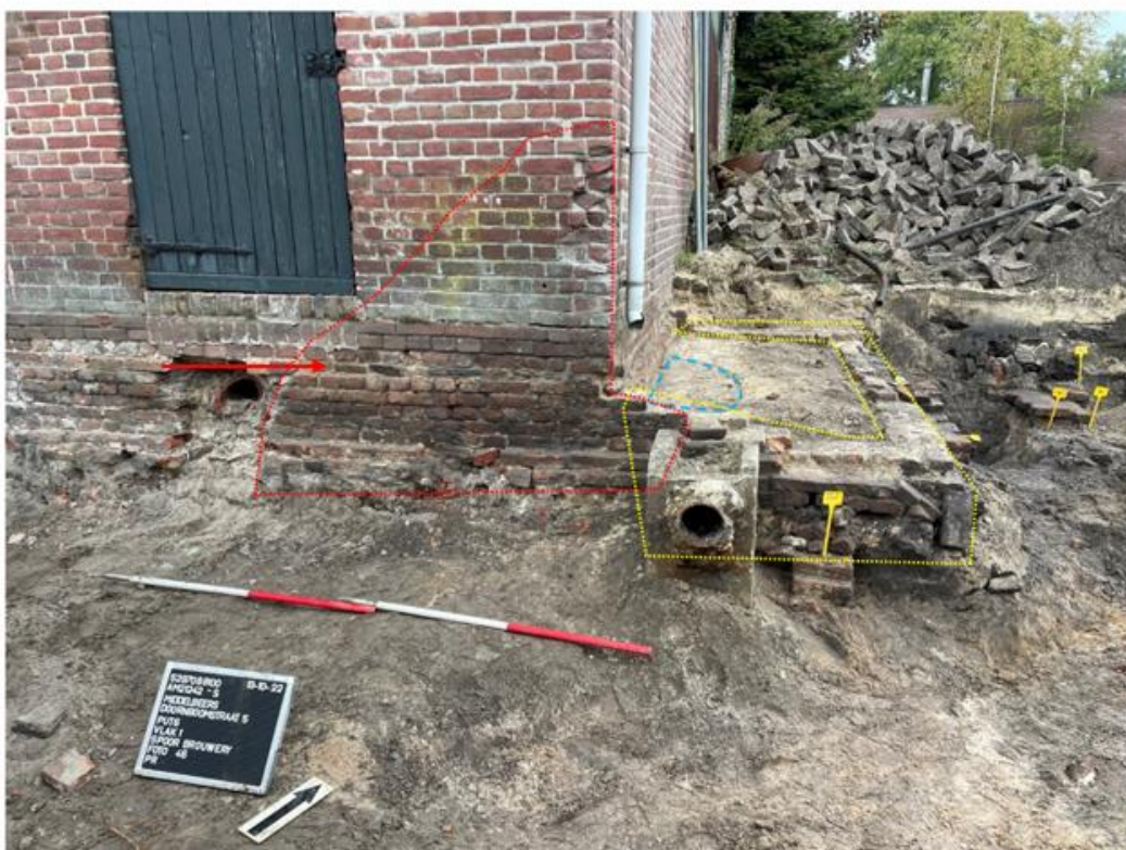
Figuur 19. De oostelijke helft van de zuidgevel van de brouwerij, in geel de afgebroken uitbouw, in blauw spoor 118 (vermoedelijk een waterput) en in rood het optrekkende vocht in de muur. Bij de rode pijl bevinden zich de plavuizen en IJsselsteentjes.
