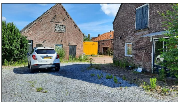
Figuur 12. Foto achterzijde bebouwing. Foto gemaakt vanuit het zuidwesten richting het noordoosten.
