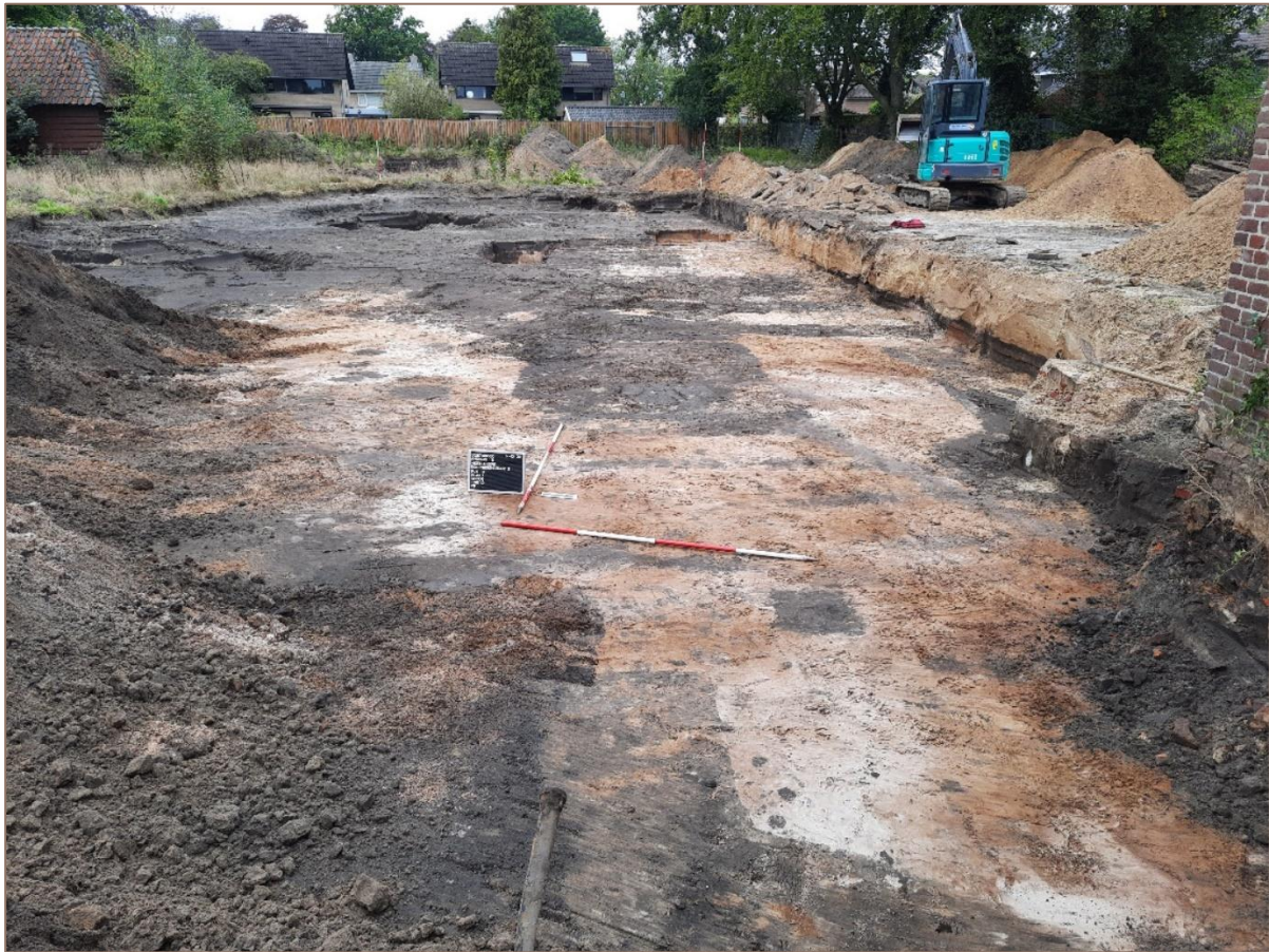
Figuur 5: Vlak 1 in WP 6 gezien vanaf de zuidwestelijke hoek van de brouwerij.
