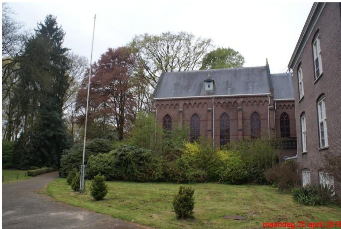
Zicht langs de voorgevel in de richting van de kapel en....
