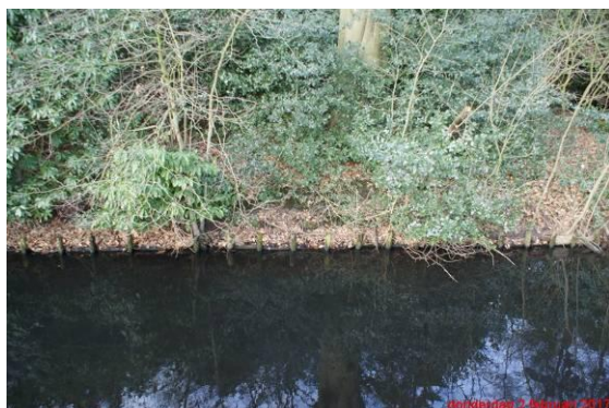
Deels verdwenen beschoeiing met plaatselijk afkalving van de oevers langs vak 1b en de Montfortlaan (afb. rechts)
