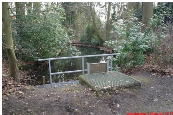
De regelbare overstort ter hoogte van de Lourdesgrot met de afwatering naar het agrarische deel
