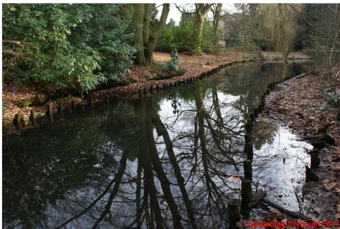
...omgekeerd zicht in de richting van het kloostercomplex; duidelijk zichtbaar de vervallen beschoeiing en de afgekalfde oevers
