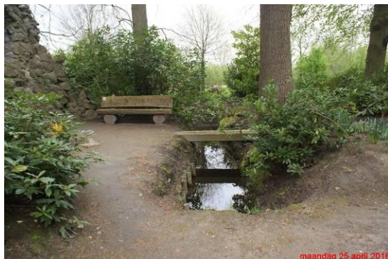
De regelbare overstort ter hoogte van de Lourdesgrot met de afwatering naar het agrarische deel
