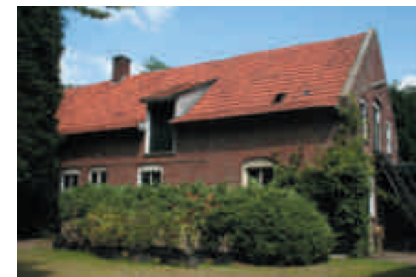
Afb.4 Boerderij op het erf achter het hoofdgebouw.
