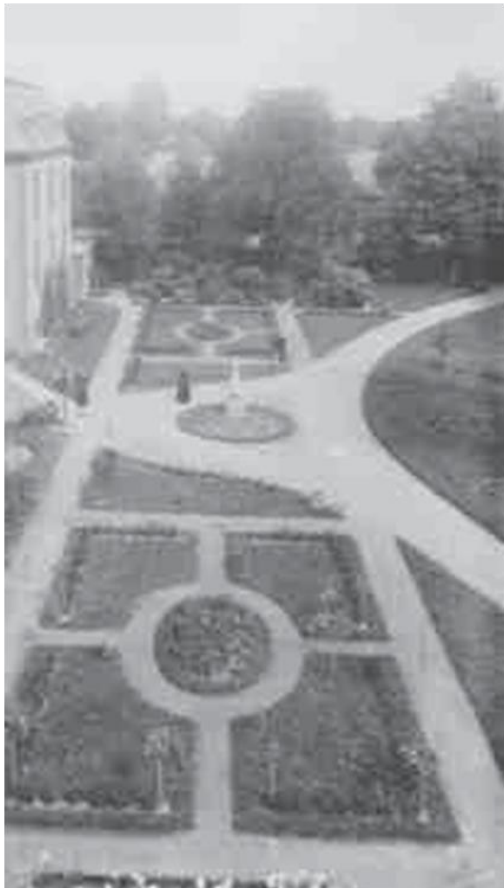
Afb.3.14 Formele aanleg van de entree, langs de gevel (1918)
