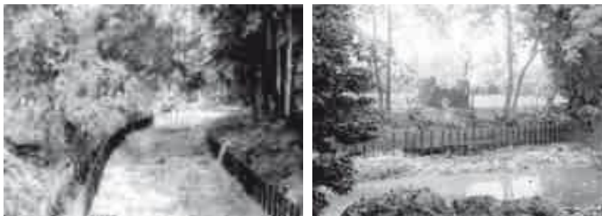
Afb. 4.2.16 en 4.2.17 Herstelde en aangebrachte beschoeiing in de jaren '70; rechts de beschoeiing bij de 'Zwanenburcht'.
