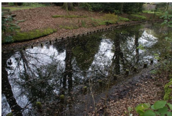
Afb. 4.5.14 en 4.5.15 Restanten van de beschoeiing; duidelijk zichtbaar de rand in de oever van het oorspronkelijke waterpeil.
