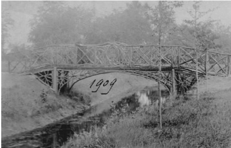
Afb. 4.2.14 Rustieke brug, gemaakt door de paters. Doorzicht naar achterliggende weide (1909).
