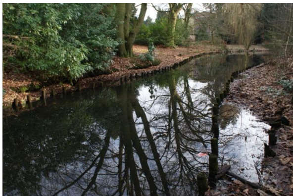
Afb. 4.5.16 en 4.5.17 Vervaging van de oeverblijning en uitspoeling van de oever. Afbeelding rechts - het deel van de vijver langs de Montfortlaan.
