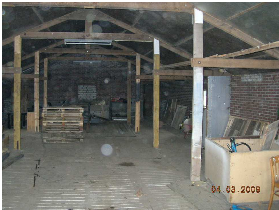
BINNENZIJDDE VOORMALIGE VARKENSSTAL EKERSCHOTWEG 1A
