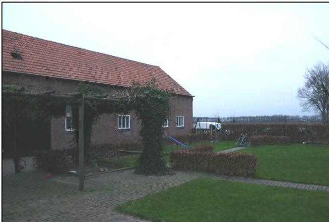
Stal 3 waar zichtstal in wordt gerealiseerd
