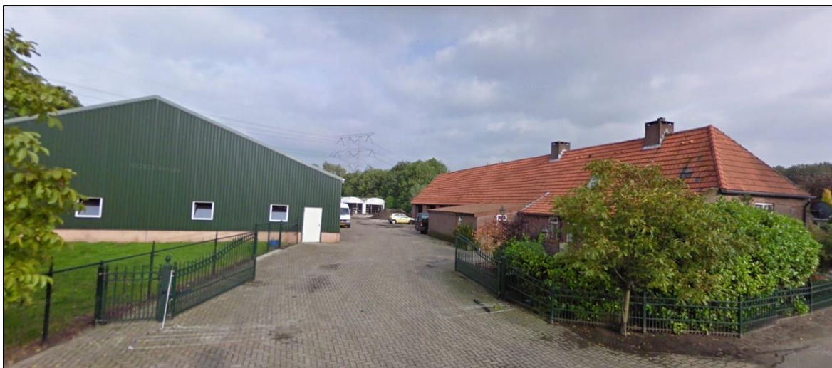
Afbeelding 6: Straatweergave vanaf Tregelaar. Aan de linkerzijde is de loods weergegeven en aan rechterzijde de woonboerderij. Aan de achterzijde is een deel van de tunnelkassen zichtbaar. (Bron: Google Streetview)
