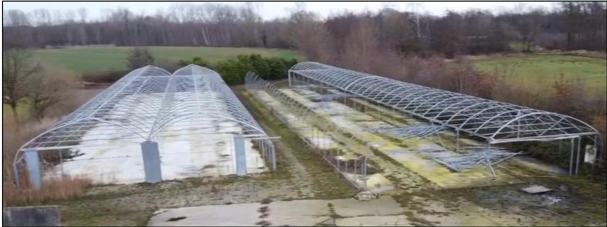
Afbeelding 26: Aan de linkerkant is tunnelkas 1 weergegeven (deels te behouden) en aan de rechterkant is tunnelkas 2 weergegeven (volledig te slopen).
