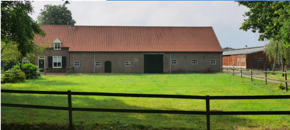
Langgevelboerderij Straatsedijk 6 is een beeldbepalend pand uit de Wederopbouwperiode.
