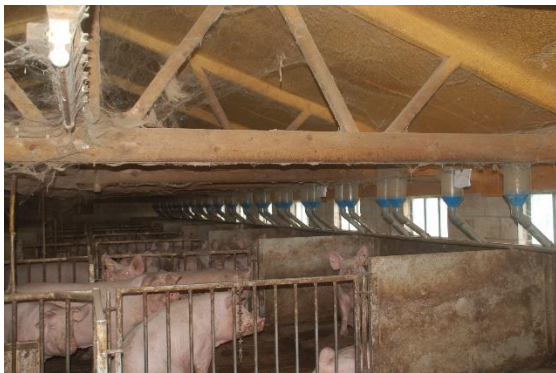
Afbeelding: binnenzijde stal 2, met geïsoleerd plafond
