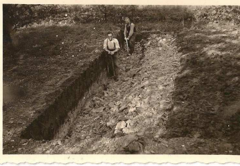
Oktober 1950 Graafwerk Kersenblok 1.30 meter diep. A. v. Summeren, G. deBresser
