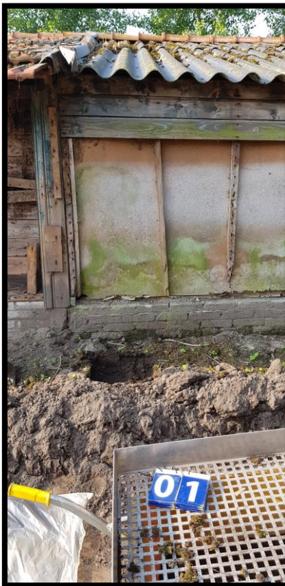
Foto's inspectiegaten en sleuven
