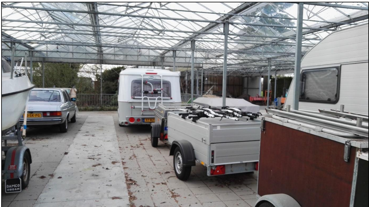
Figuur 11: Kassen in het noordelijke deel van het plangebied (foto genomen tijdens de uitvoering van het veldwerk op 12 februari 2020).
