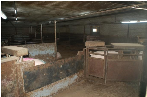
Afbeelding: binnenzijde varkensstallen
