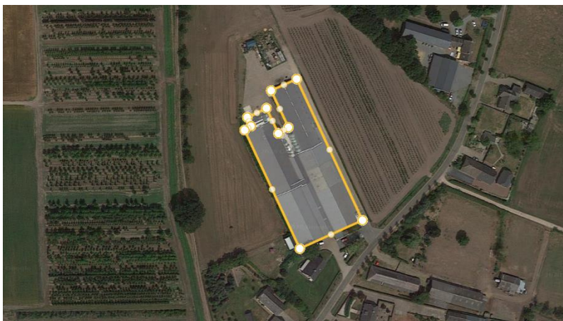
Afbeelding: situatieschets met in geel de te slopen bebouwing Bron: google earth
