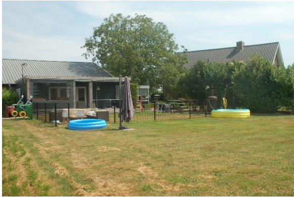
Afbeelding: Te behouden bijbouw met achterzijde woning.
