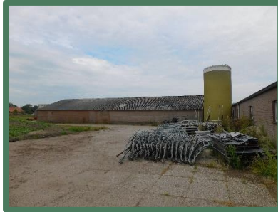
achterzijde loods 2 met rechts stal 5
