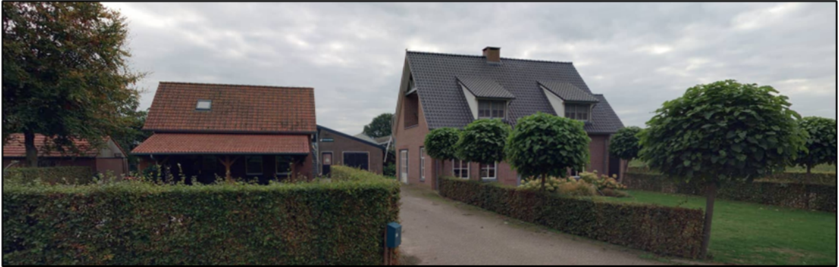
Zichtzijde vakantiewoning + bedrijfswoning met bestaande beukenhaagstructuren
