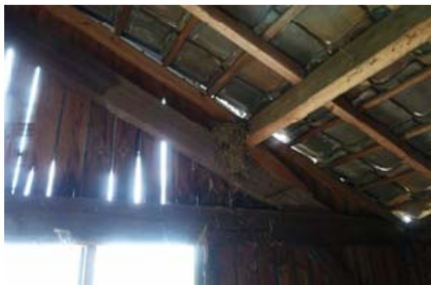
Foto 3. Te slopen schuur
