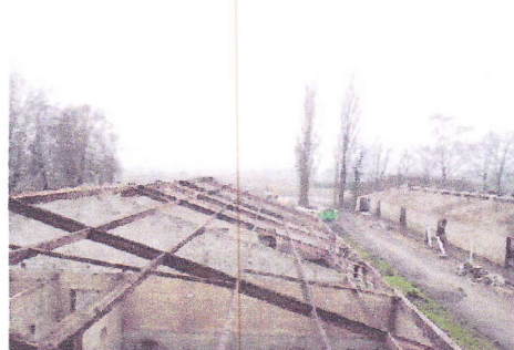
foto 8: Zeugenstal. Gifplaten verwijderd. Container op de achtergrond
