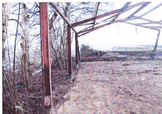
foto 2: Wand van asbesthoudend plaatmateriaal verwijderd.
