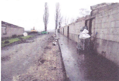
foto 3: Wand van asbesthoudend plaatmateriaal verwijderd.
