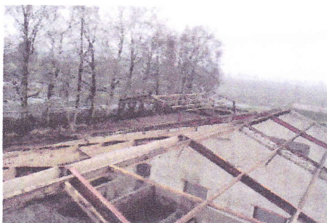
foto 5: Gifplaten verwijderd. Zeugenstal en opstal VH2 op de achtergrond.
