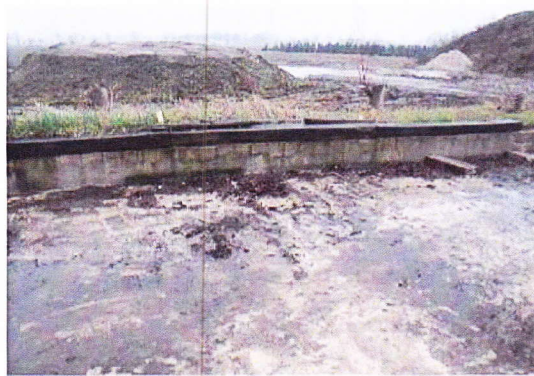
foto 4: 3 stapels asbesthoudend plaatmateriaal verwijderd.
