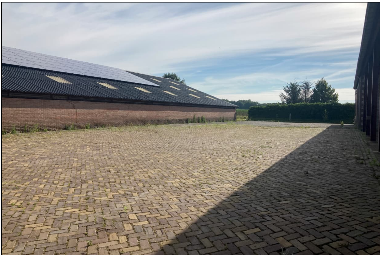
Figuur 8: Foto van de verharding tussen de stallen. Onder deze verharding is ook nog een mestput gelegen
