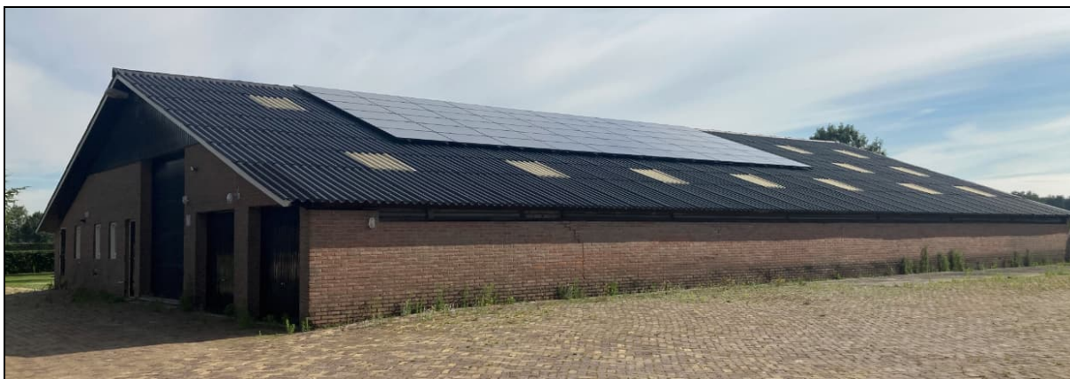
Figuur 6: Foto van de loods voor caravanstalling binnen het plangebied
