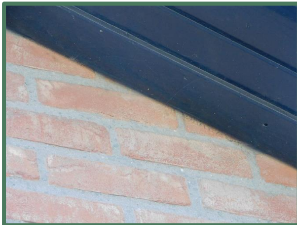
Strak geplaatste overstekbetimmering
