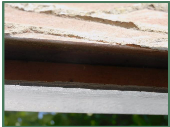
Afgesloten invliegmogelijkheid tussen de gevel en de muur
