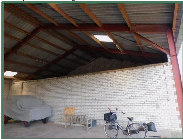
Open deel van de loods met zolder
