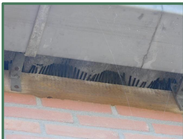
Vogelschroot onder golfplaten loods
