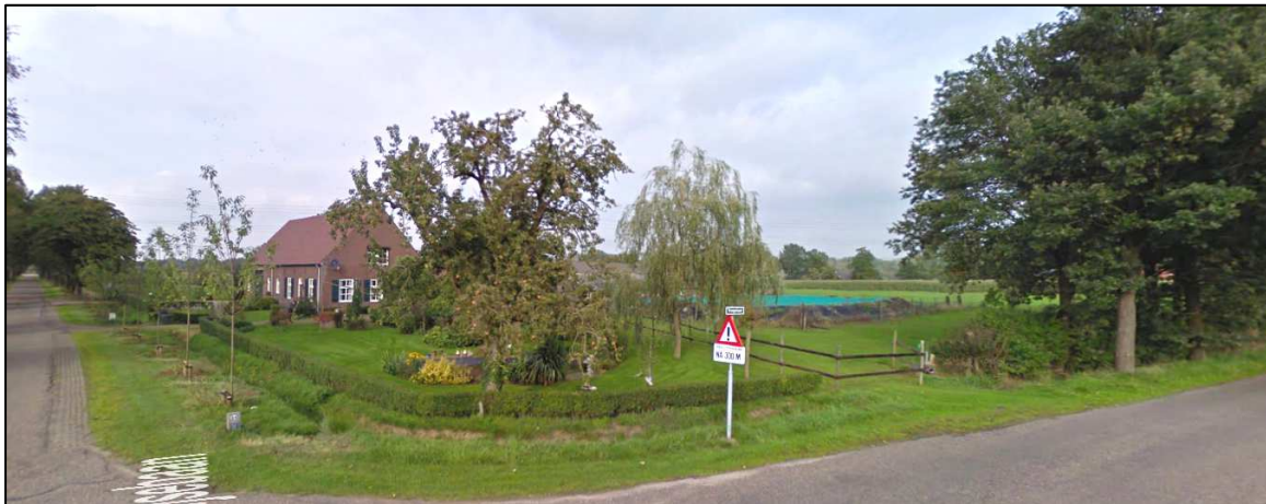
Figuur 13: Bestaande situatie planlocatie Meierijsebaan 6
