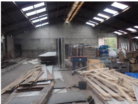
Fig.6 De te slopen stal inpandig
