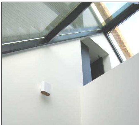
Figuur 7: Goed ingepaste voorziening voor passieve verwarming in een ambachtelijk vormgegeven bouwvolume
