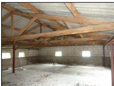
Figuur 6. Binnenzijde zuidelijke varkensstal.
