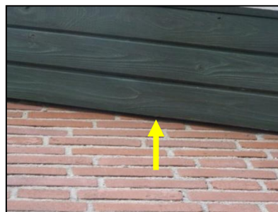
Figuur 22. Ruimte achter betimmering.
