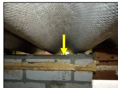
Figuur 23. Spouw van boven toegankelijk.
