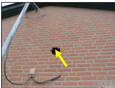
Figuur 21. Opening tot spouwmuur
