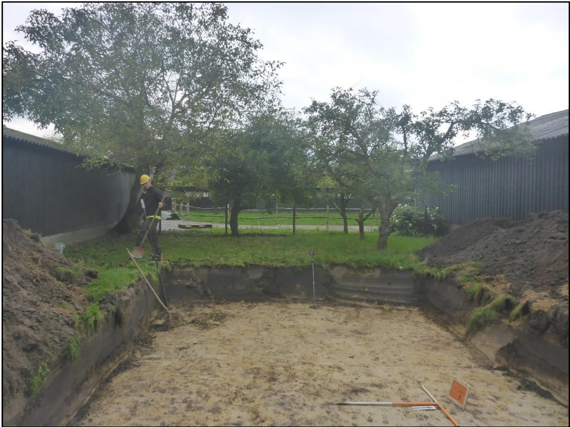
Figuur 2. Werkput 4 tussen twee bestaande gebouwen in.
