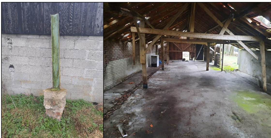
Figuur 12: Links: Foto van één van funderingspalen van de schuur in het zuidwesthoek van het plangebied. Rechts: Foto van de binnenzijde van de schuur in het zuidoosten van het plangebied. Op de foto is de betonvloer en zijn de houten funderingspalen zichtbaar.
