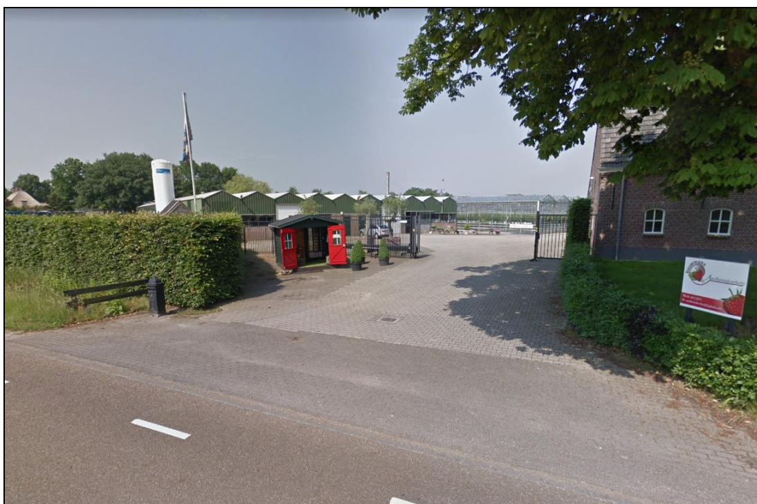
Figuur 7: Ontsluiting perceel en bedrijfsgebouw
