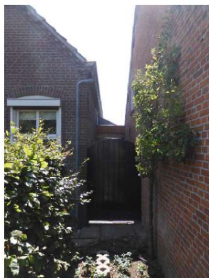
Links: Het uiterste linkerdeel van de achtergevel is uitsluitend vanaf dit standpunt zichtbaar.
