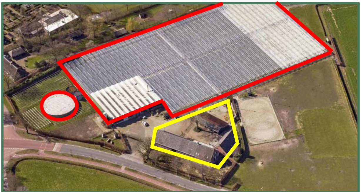
Luchtfoto Beerseweg 6 bestaande situatie. Bron: Crijns Rentmeesters.
