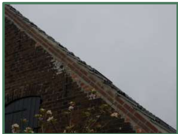
Gemetselde dakrand en dakpannen
