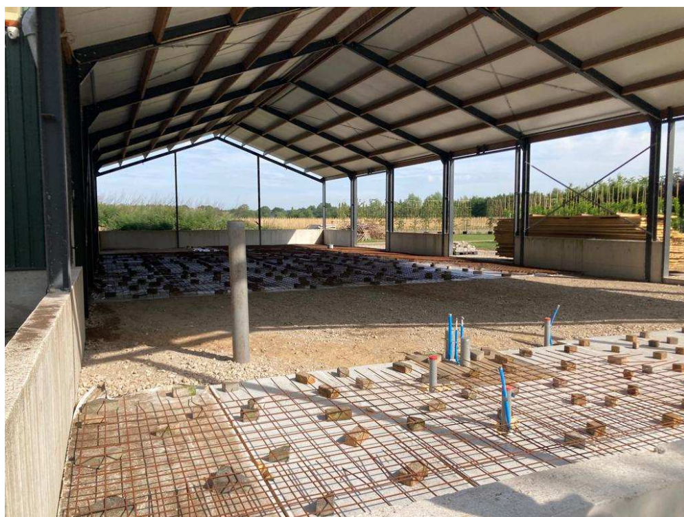
• Afbeelding 8: in aanbouw zijnde loods aan de zijkant
