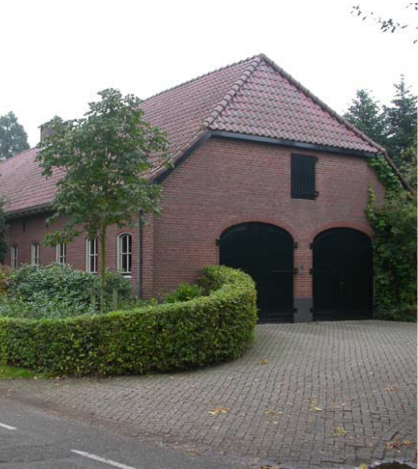
VOORBEELD BESTAANDE BEBOUWING
