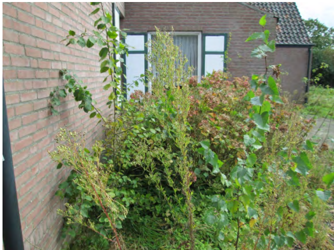
Figuur 9: Achterzijde woning
