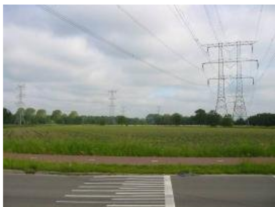
Hoogspanningmasten over Wolvendijk
