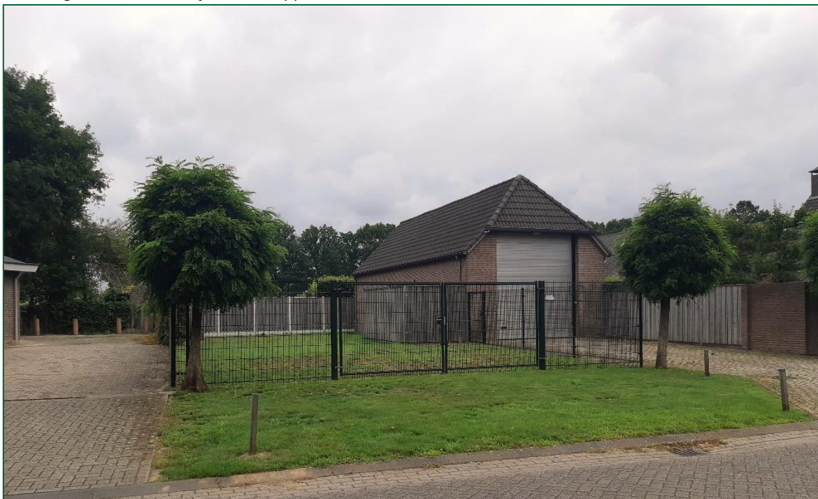
Afbeelding 4. Aanzicht huidige situatie perceel Duivendijk
