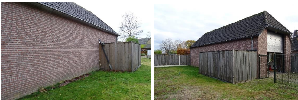
Afbeelding 5 en 6: Bestaand bijgebouw op aangrenzend kavel, waar deels tegenaan gebouwd gaat worden.
