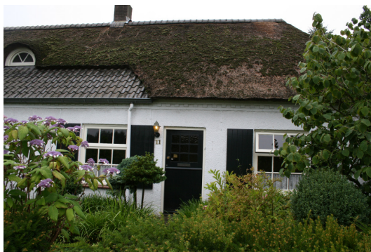
Voorgevel woonhuis gedeelte
