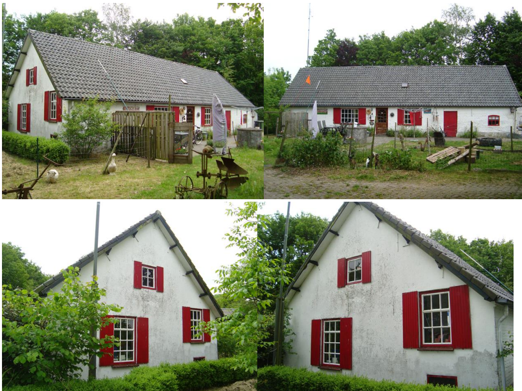
Aanzichten bestaande woning
