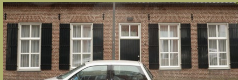
Staande gevelopeningen met roedeverdeling
