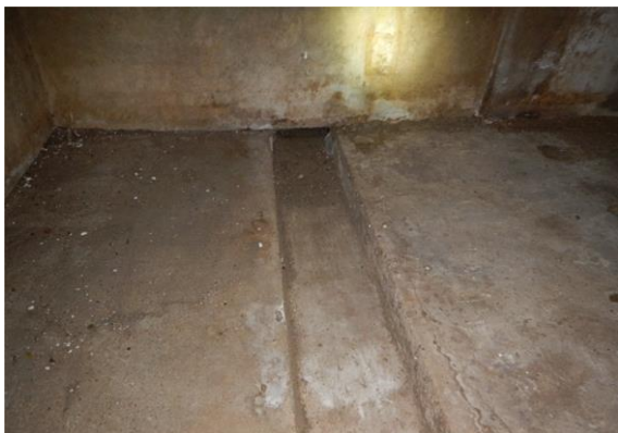
Betonvloer met gemetselde goten
