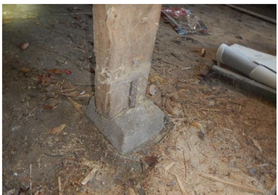
Houten spant op betonnen poer
