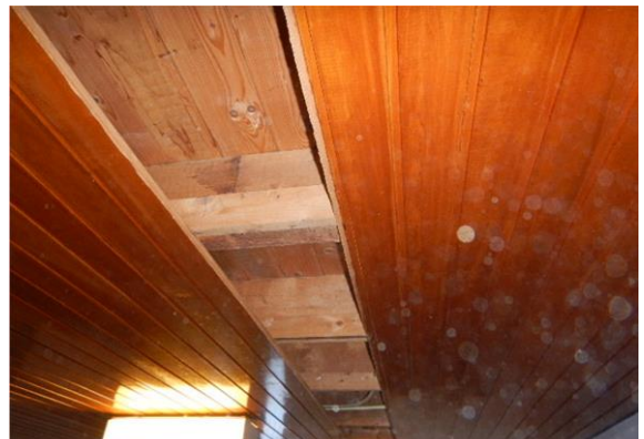
Houten schrootjes tegen houten balklaag
