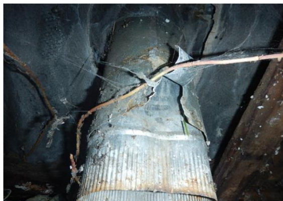
Geen koord bij afvoer geiser in kalverstal
