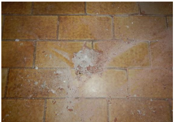
Tegelvloer op schone beton
