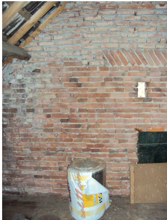
21 De opnieuw in 1972 opgemetselde top van de noordelijke kopgevel. Daaronder de restanten van de kopgevel uit 1881.
