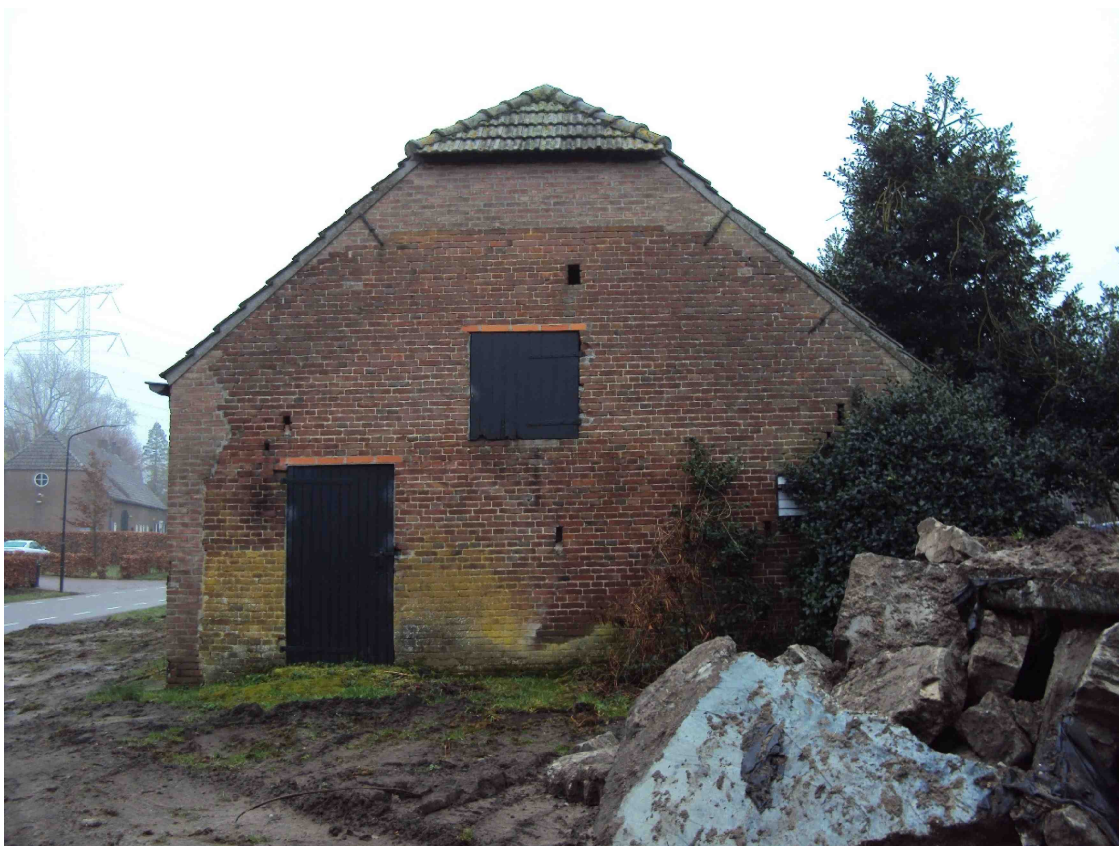
15 Noordelijke kopgevel met restanten bouwmuur uit periode 1881
