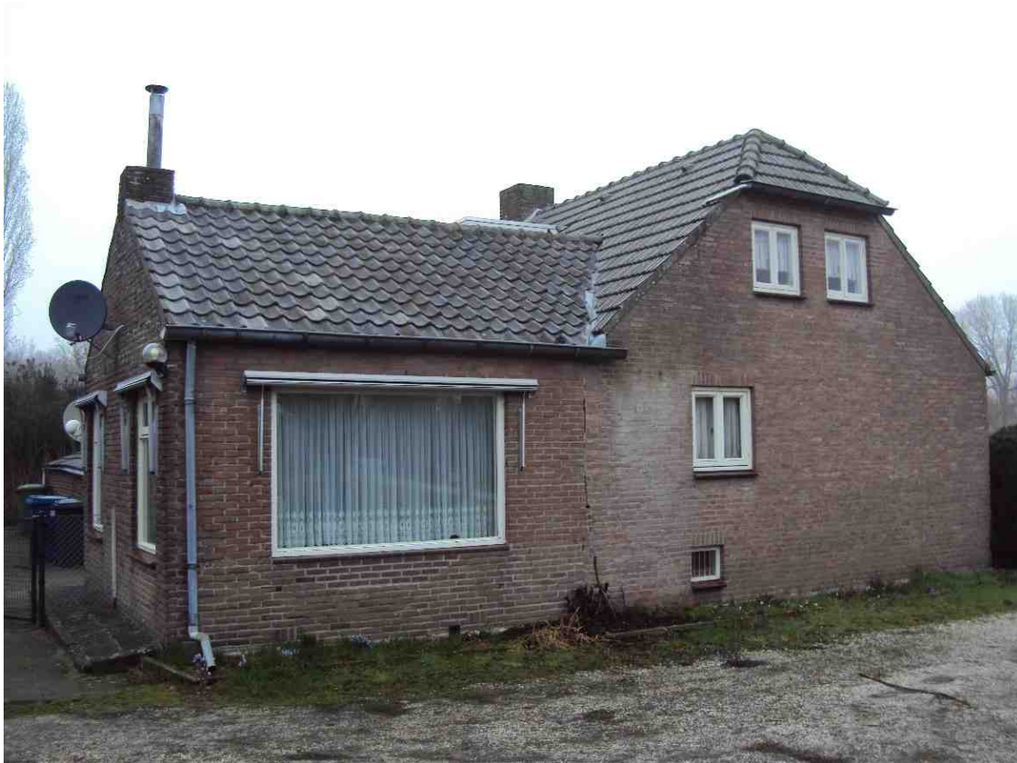
14 Zuidelijke kopgevel met aanbouw uit 1968
