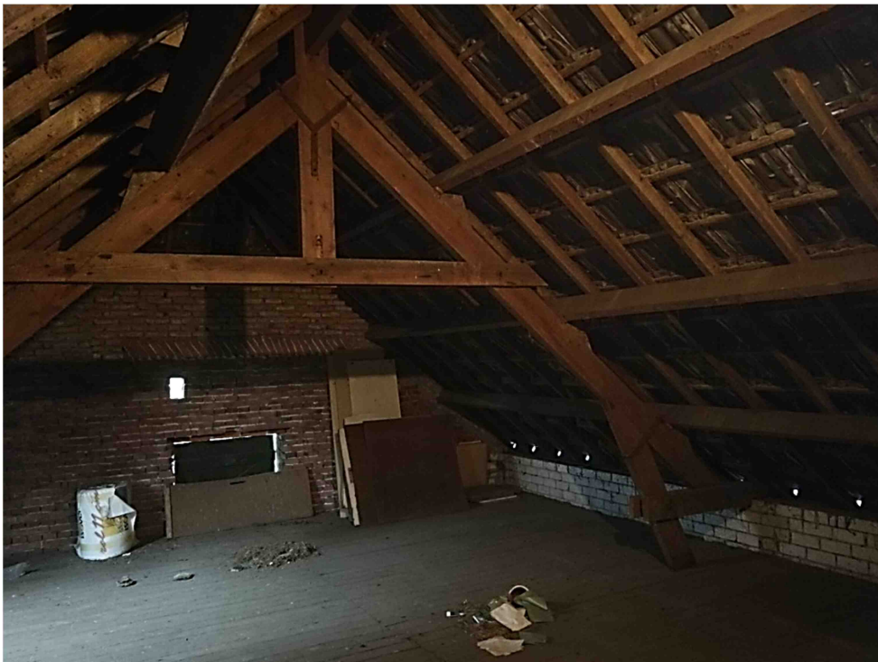
22 Spant, kapconstructie en kalkzandstenen binnenspouwblad uit periode 1972. Restanten van kopgevel aan de noordzijde uit periode 1882.
