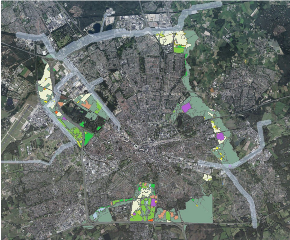
Figuur 37 Buisleidingen in Eindhoven
