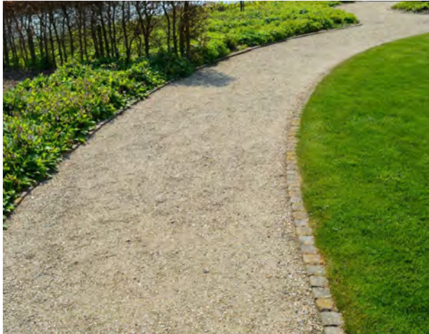
Halfverharding voor struinenpaden
